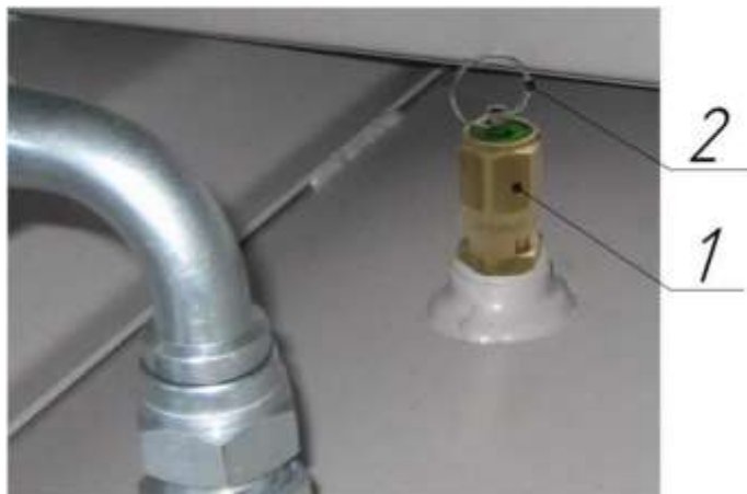
Рисунок 9 – Клапан предохранительный пружинного типа
