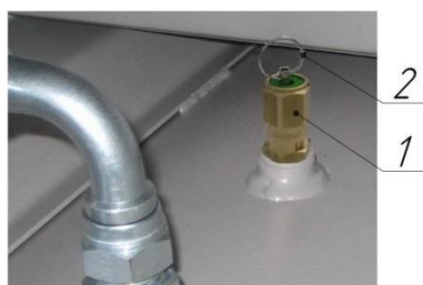
Рисунок 8 – Клапан предохранительный пружинного типа
